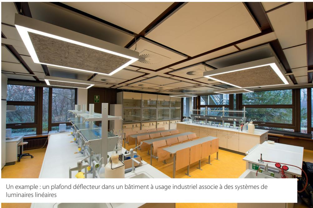
Un exemple : un plafond déflecteur dans un bâtiment à usage industriel associé à des systèmes de luminaires linéaires
